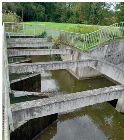
Barrage de l'étang de la Loy
