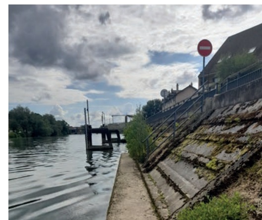
Digue du Pré Long à Lagny-sur-Marne
