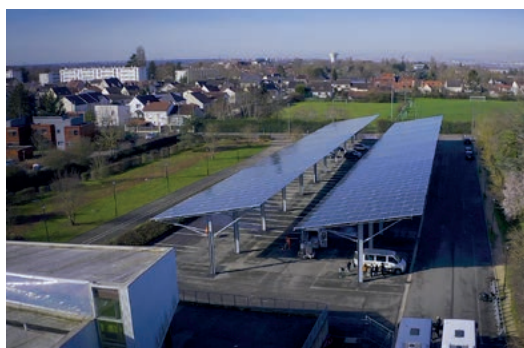
Le parking du centre aquatique couvert par deux ombrières photovoltaïques.
