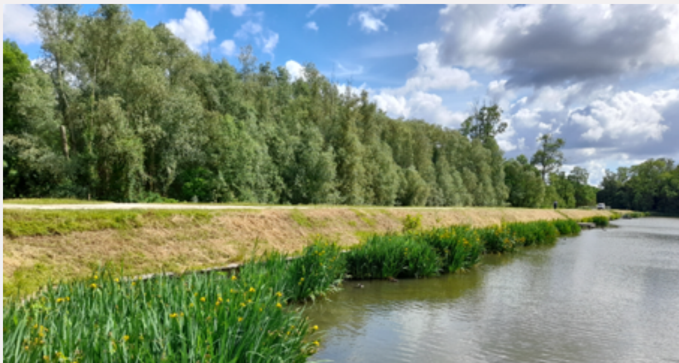
Barrage de l'étang de la Loy
