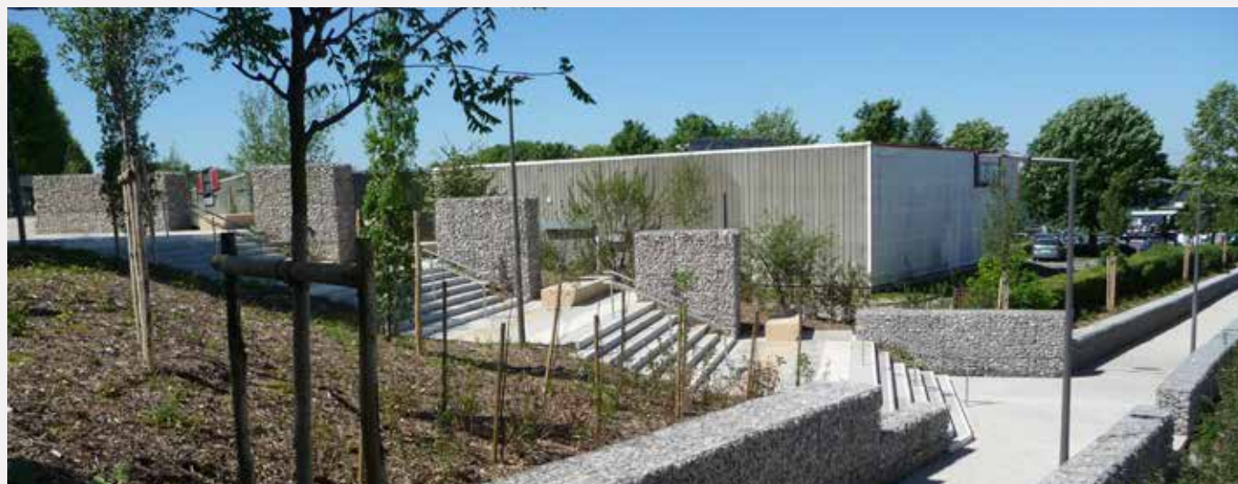
▲ Liaison piétonne du RD 418 vers la zone commerciale de la ZAE de Marne et Gondoire à Saint-Thibault-des-Vignes
