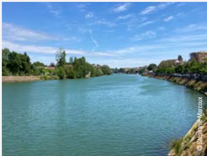
▲ Digue du quai du pré long
