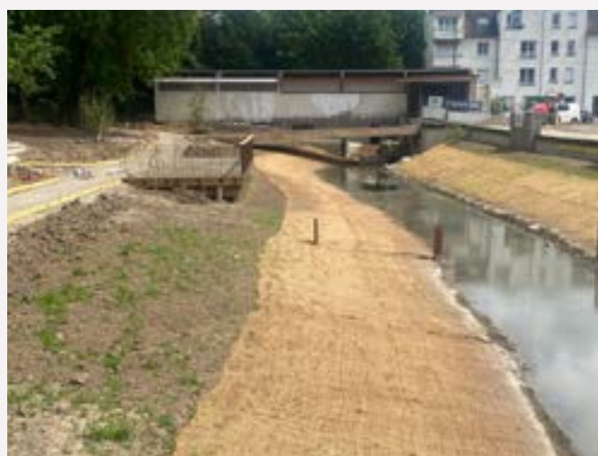
▲ Remise à ciel ouvert du ru du bras Saint-Père
