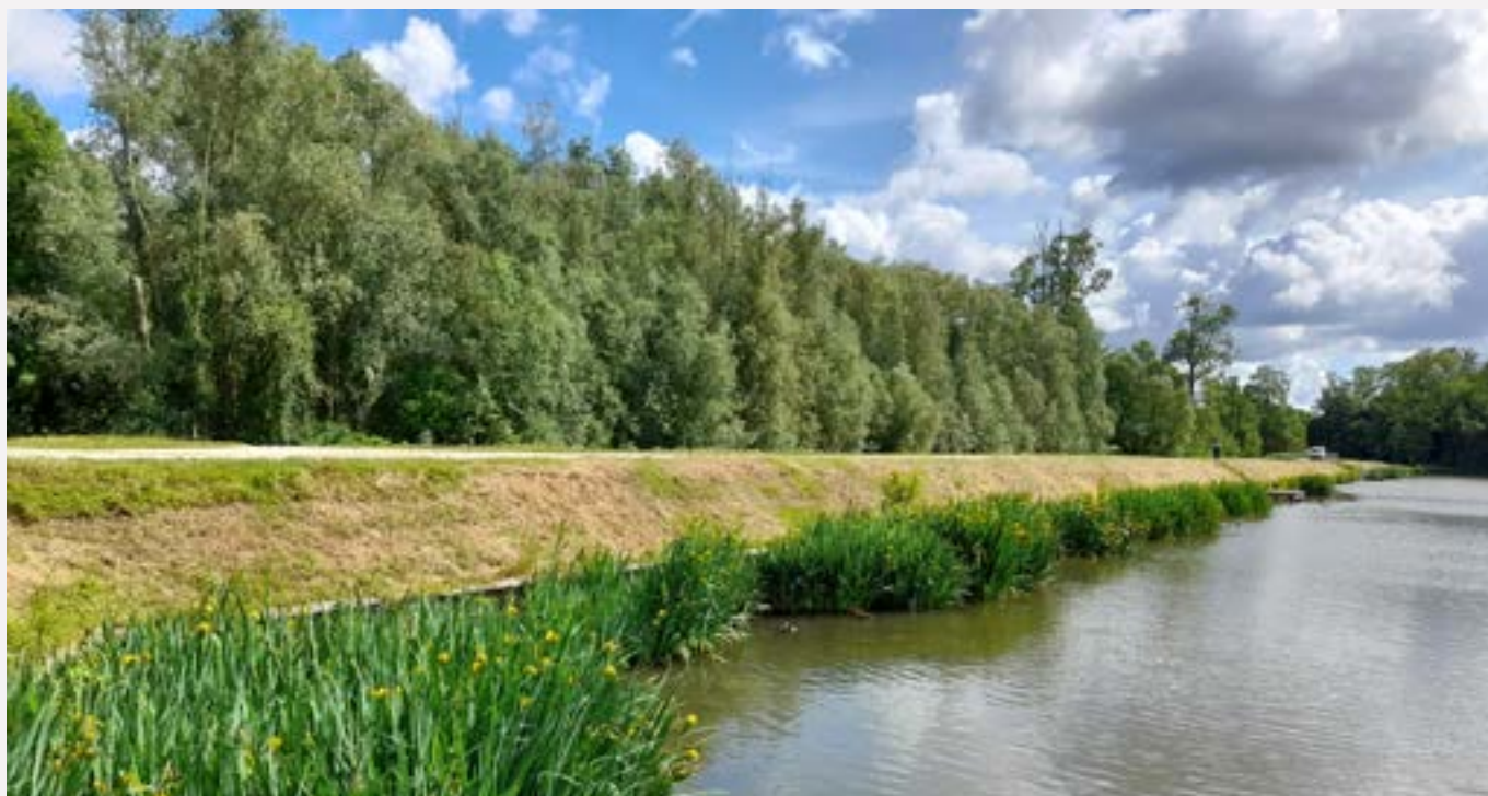
Barrage de l'étang de la Loy
