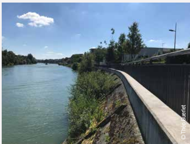
▲ Digue du quai du Pré Long
